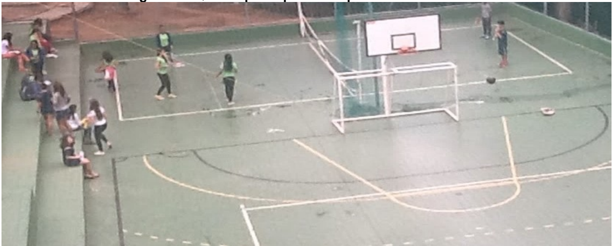
Figura 6 – Quadra poliesportiva e quadra de vôlei anexa
